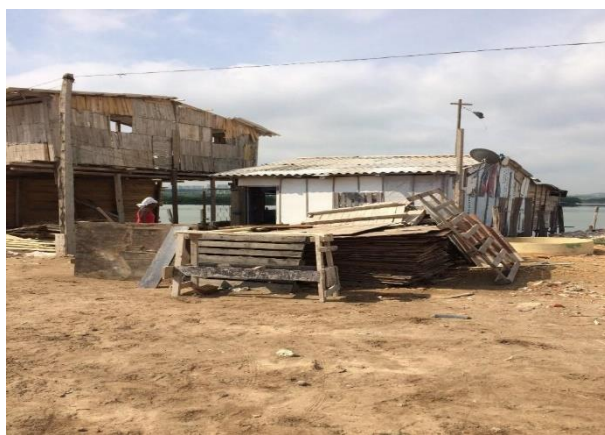
Figura 11. Viviendas sobre la Ciénaga. Fuente: Tomado del archivo de fotos de la Investigación sobre la precariedad en el Barrio Las Flores de Barranquilla. 2018 (Velásquez – Briceño)
